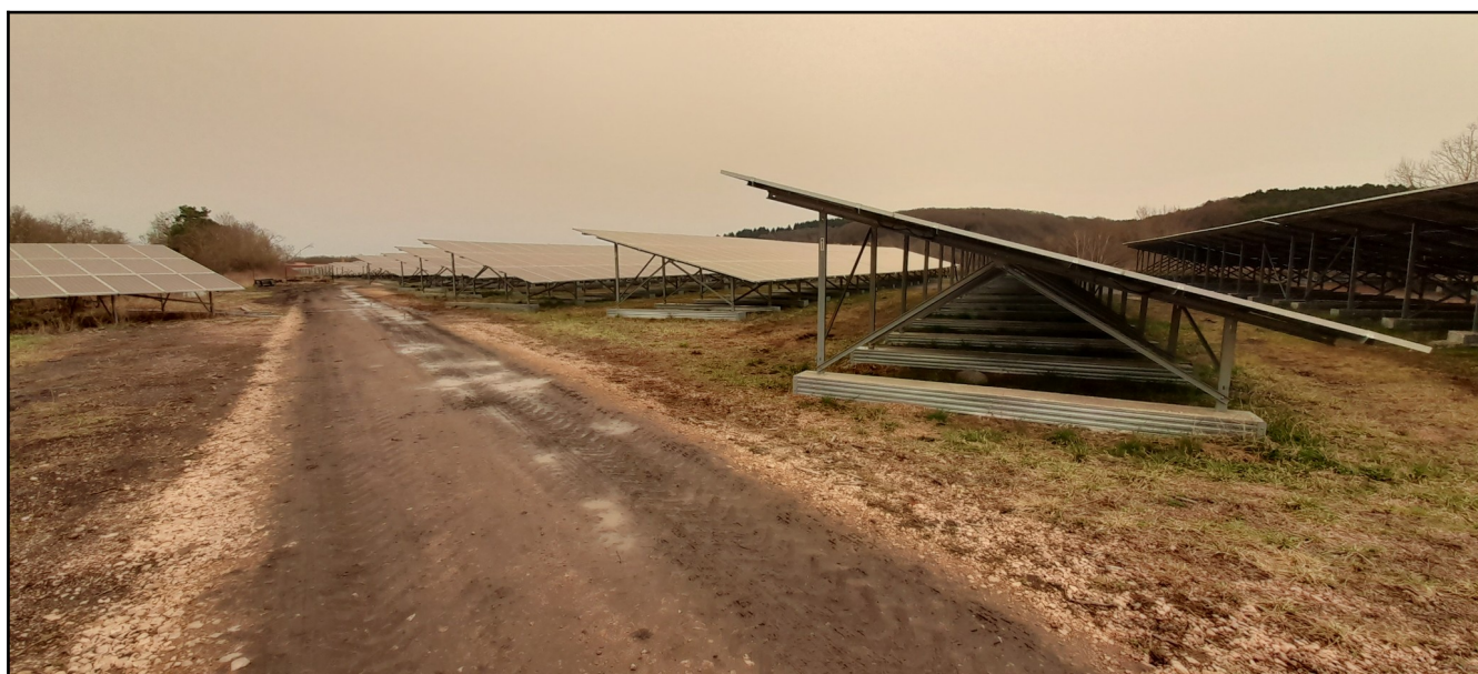
Vue n°4 : Structure et module photovoltaïque en zone grevée de servitudes 2A
