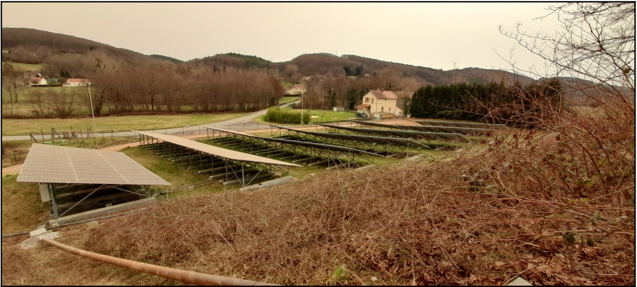
Vue n°5 : Structure et module photovoltaïque en zone grevée de servitudes 1
