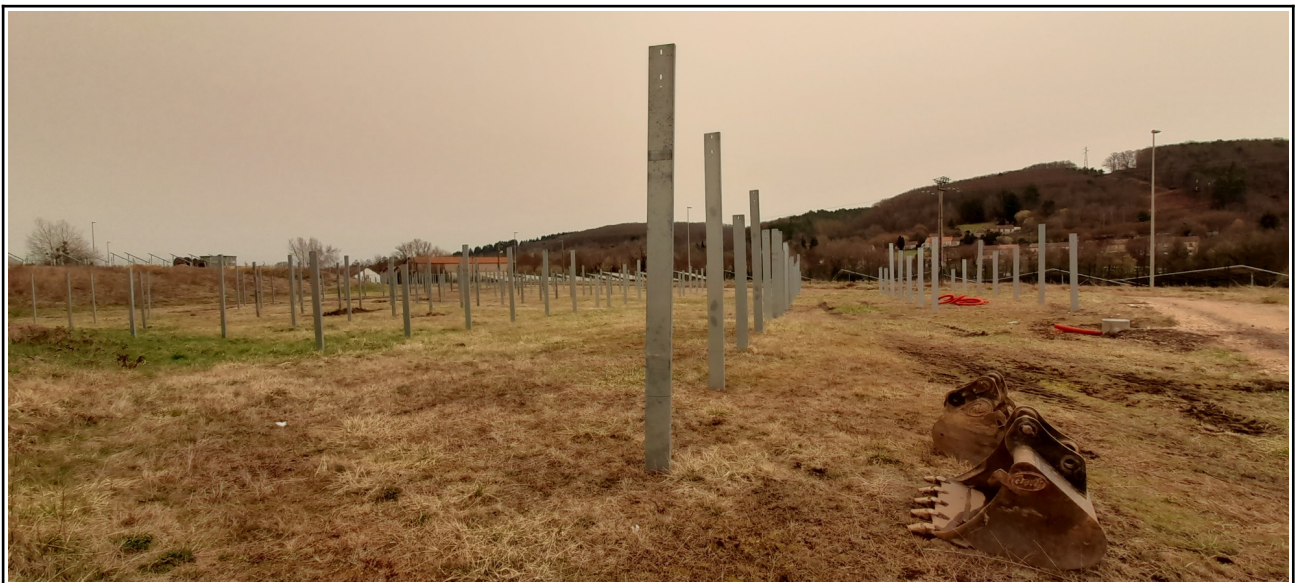
Vue n°6 : Pieux en zone grevée de servitudes 3
