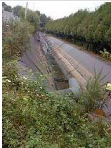
Bassin de confinement des eaux d'extinction en cours de curage
