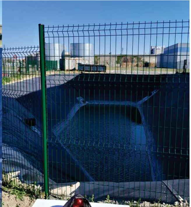
Photo 10 : clôture autour du bassin :
