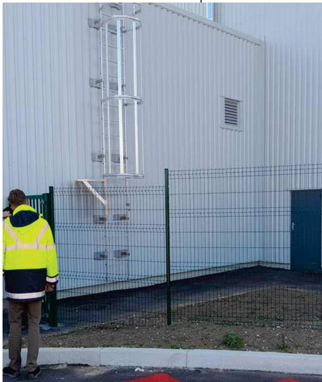
Photo 13 : échelle d'accès aux panneaux :
