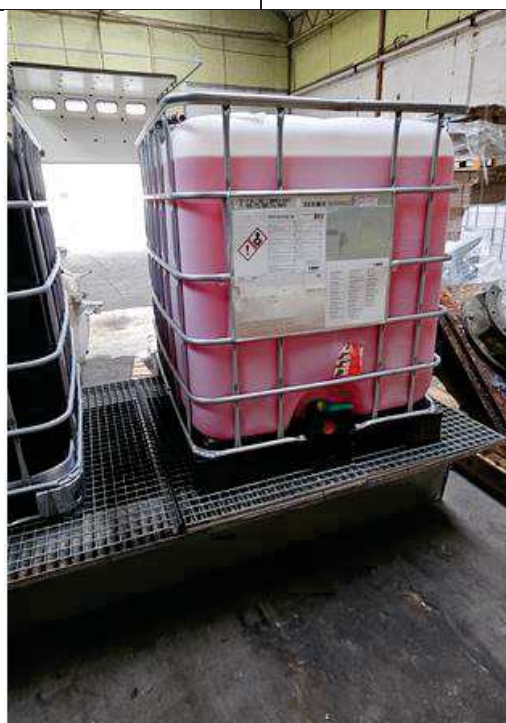
Glycol sur rétention Photo transmise par l'exploitant le 5/12/24
