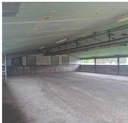
Fumières vidées et nettoyées après l'inspection
