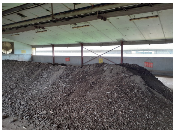
Fumières en bout de bâtiment d'élevage
