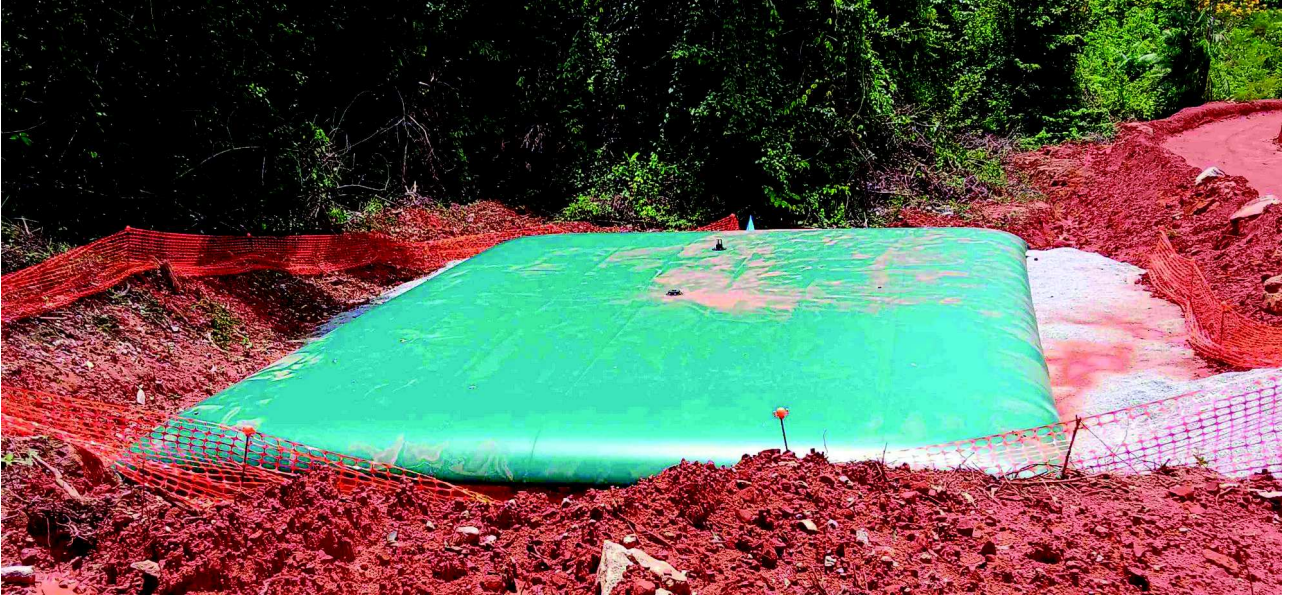
Citerne incendie souple
