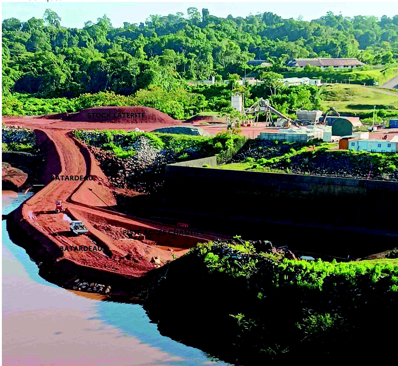
Batardeau et stock latérite
