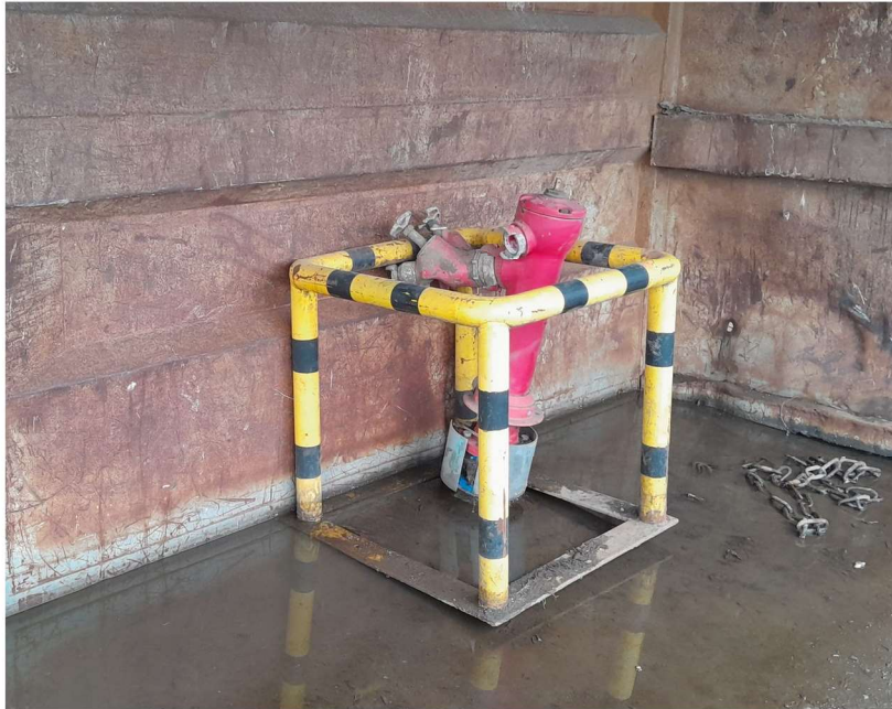
Photographie du poteau incendie situé à proximité du chantier de démantèlement
