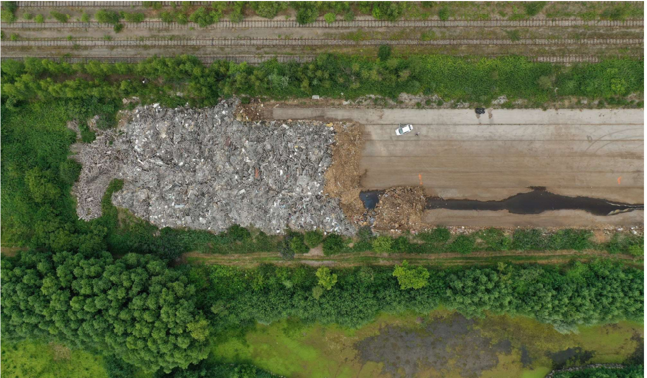
Vue aérienne de l'état du site après intervention (la marque orange la plus à droite identifie l'extrémité du tas présent avant l'opération d'évacuation par Coved)
