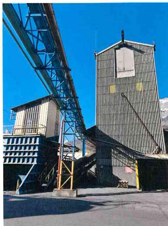
Image 3 : Installations mises à l'arrêt (tours Ameco A et B)
