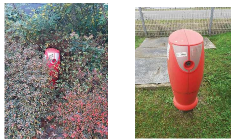
Sortie (séparateur à hydrocarbures) – dispositif à surveiller
