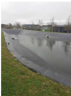
Bassin d'orage et de confinement du site (accès à sécuriser côté usine)
