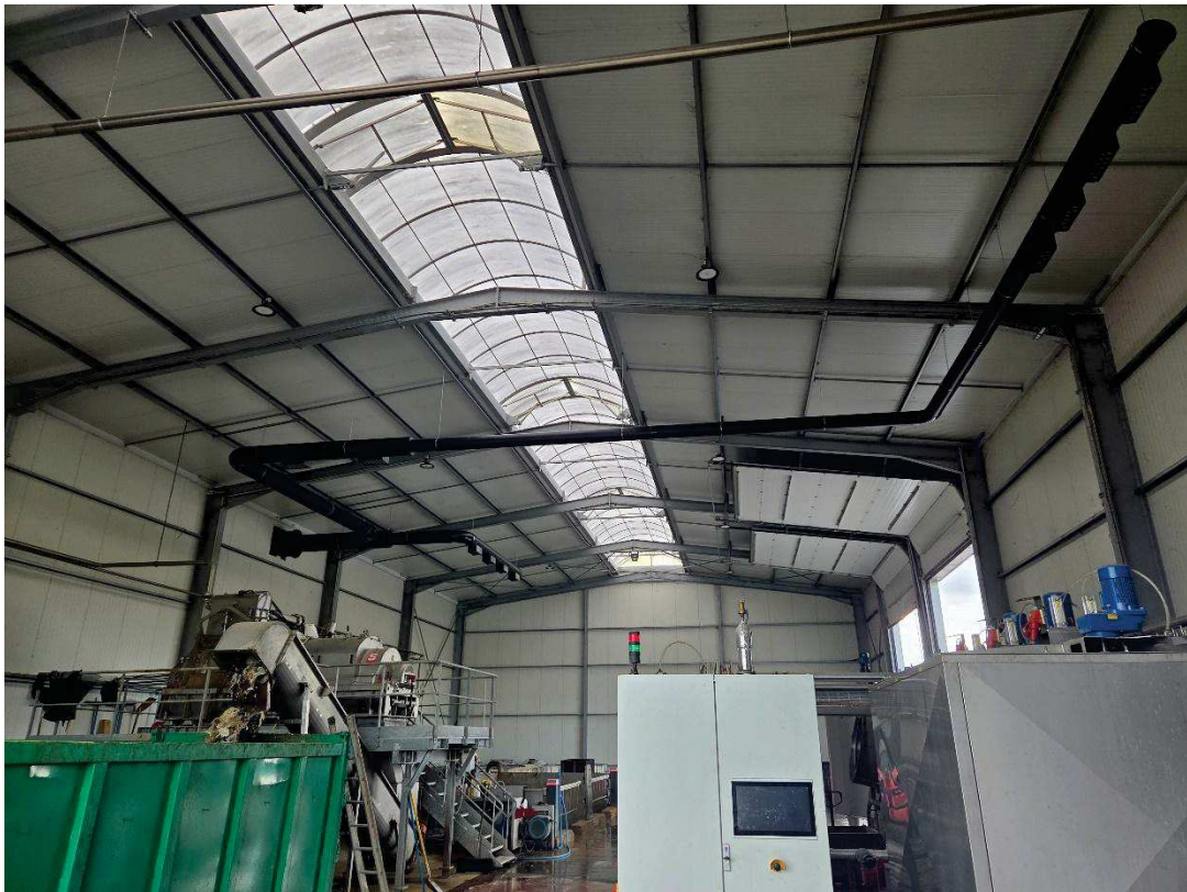
Figure 8 : Installation des canalisations d'aspiration internes des odeurs
