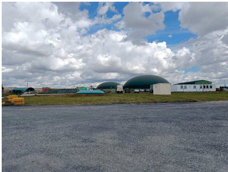
Figure 15 : Bâche de 120 m 3 d'eau d'extinction en cas d'incendie
