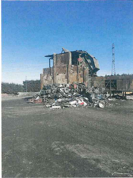
Zone ayant été sinistrée : dallage refait et plaques métalliques de protection installées au niveau du pré-broyeur
