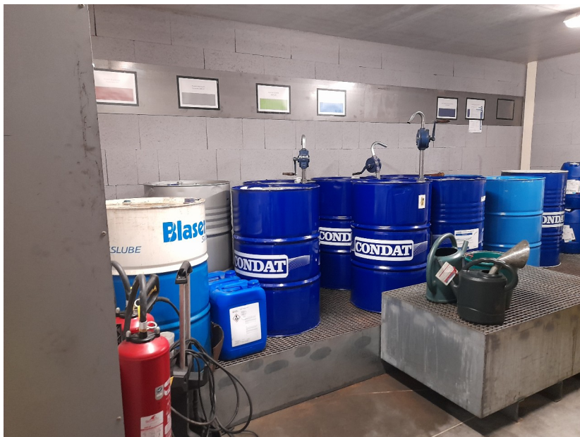
Local de stockage des huiles
