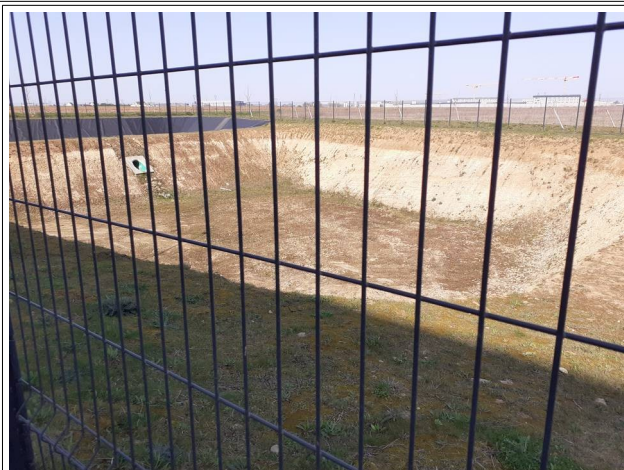
Bassin infiltration des eaux pluviales de 1337 m 3
