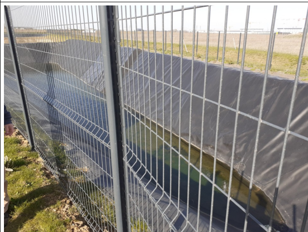
Bassin de confinement de 1800 m 3
