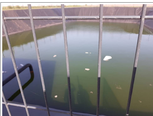
Réserve incendie de 1000 m 3
