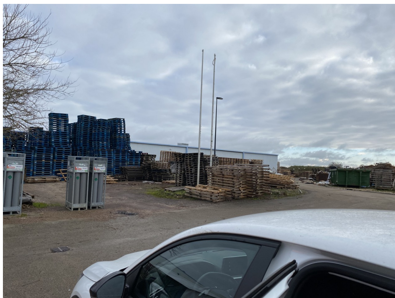
Figure 4 - Arrière du site non clôturé et sans surveillance de l'exploitant
