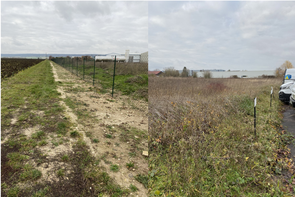
Figure 1 - Clôtures installées à l'EST du site et absence de clôtures sur la partie OUEST du site
