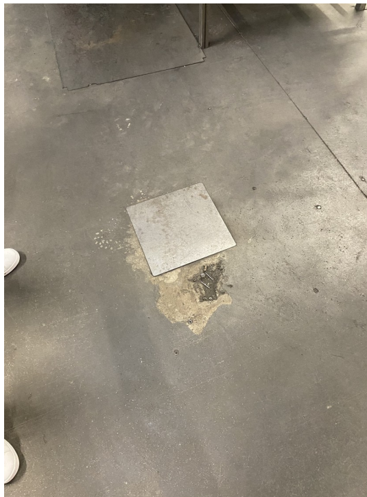
Figure 2 - Sécurisation des évacuations d'eau dans l'usine
