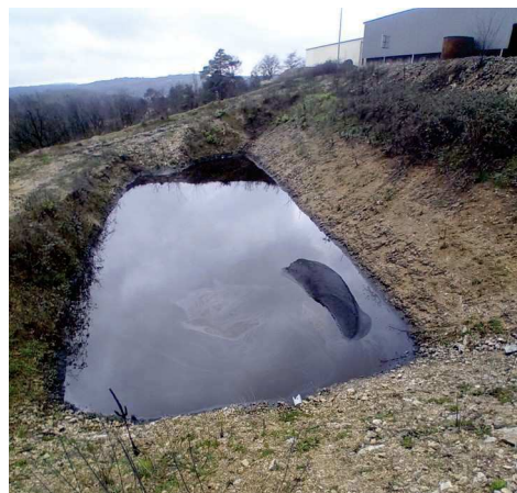
Figure : Bassin d'infiltration n°1 CENTRAL au Sud de l'installation le 12/03/2024
