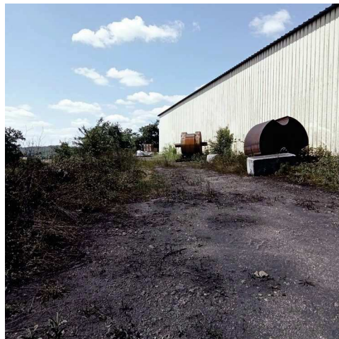
Figure 3: Voie périphérique à proximité de la sacherie
