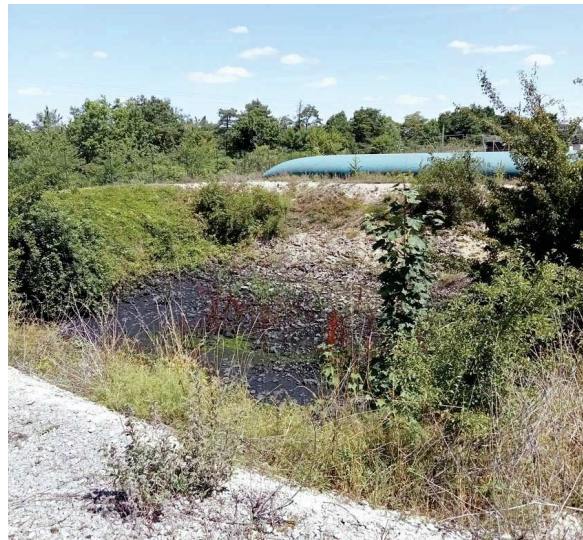
Figure 9: Bassin d'infiltration n°4 OUEST
