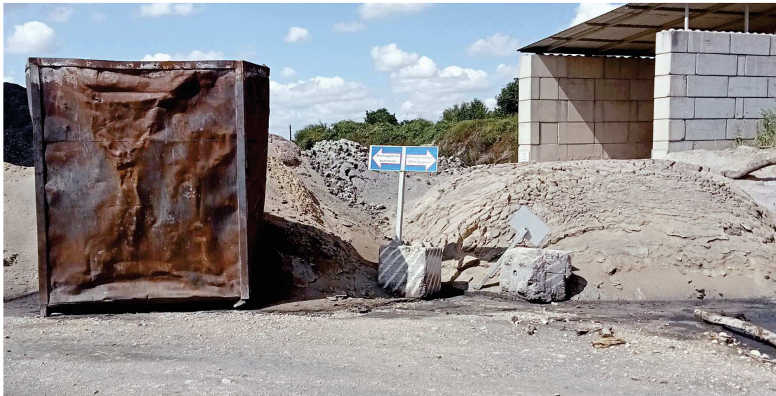
Figure 2: Stockage de sables de chaudière à lit fluidisé à même le sol
