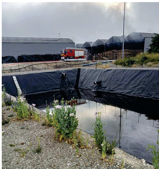
Figure 5: Photo du bassin n°4 prise lors de l'incendie du 12 juin 2023
