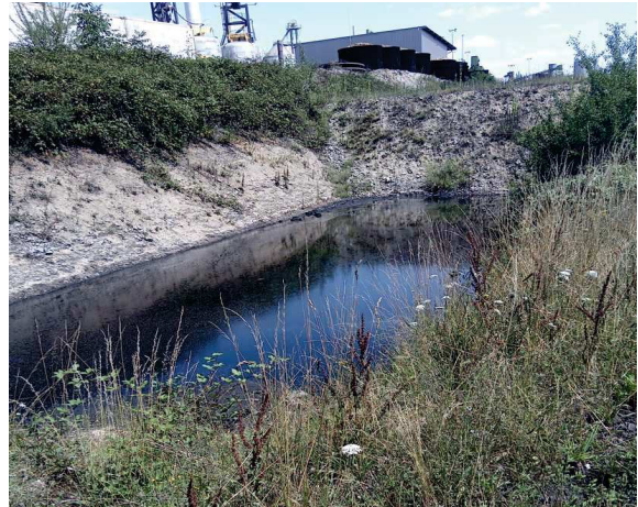
Figure 7: Bassin d'infiltration n°1 CENTRAL en charge
