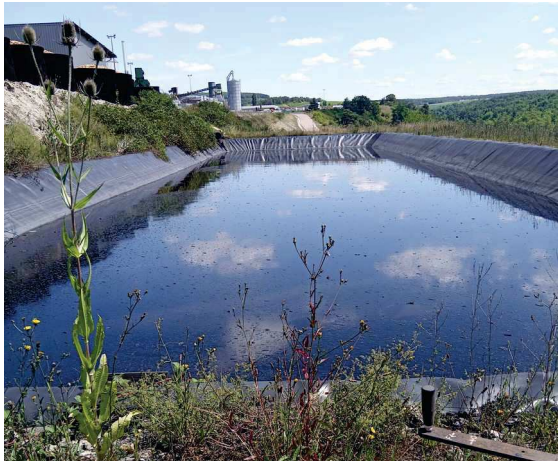
Figure 6: Bassin de rétention n°1 CENTRAL avec les matières en suspensions visibles
