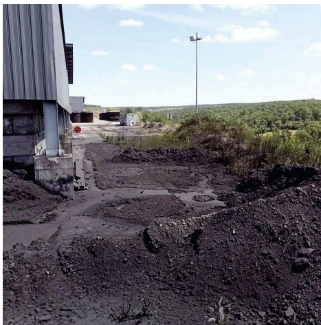
Figure 4: Voirie périphérique à proximité du stockage "Vrac"
