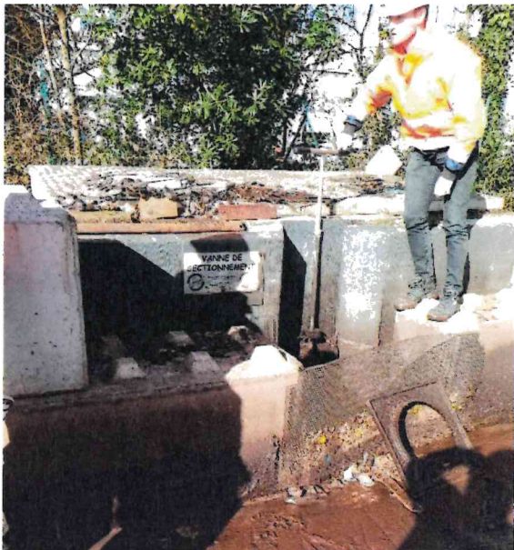
Levier d'action de la vanne d'isolement et consigne d'utilisation affichée
