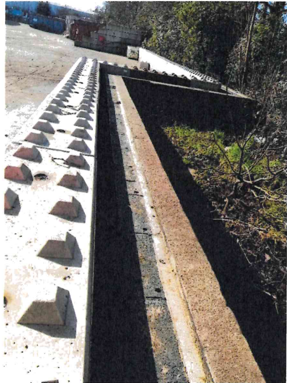
Double muret étanche en limite basse de la zone de rétention
