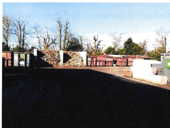
Cellules d'entreposage de bois délimitées par mégablocs béton
