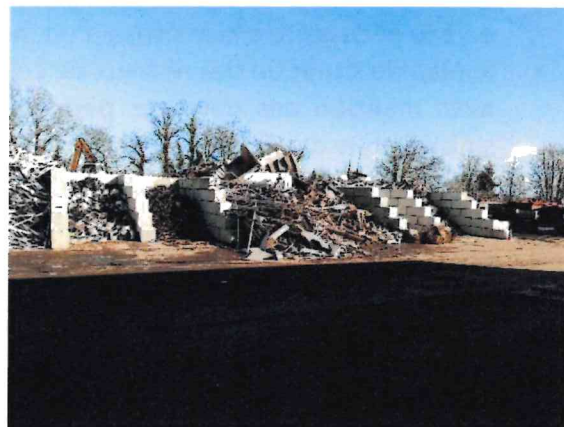
Cellules d'entreposage de métaux délimitées par mégablocs béton
