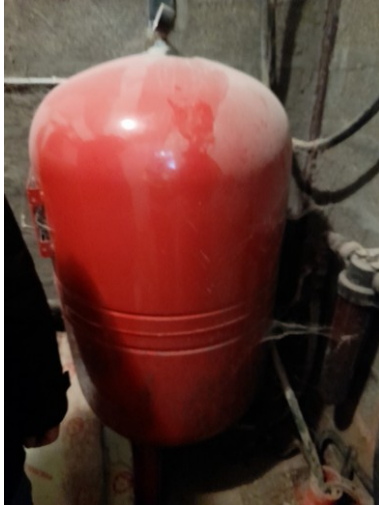
Plaque signalétique vase expansion n°série L0696077 année 2019 PS= 10 bar V= 300 litres PS*V = 3 000
