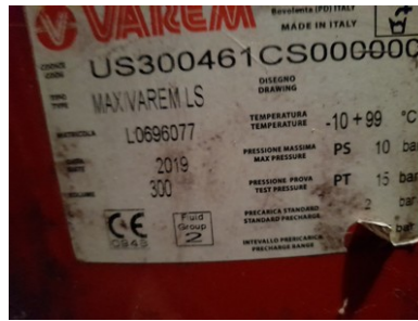
Plaque signalétique vase expansion n°série L0696077 année 2019 PS= 10 bar V= 300 litres PS*V = 3 000
