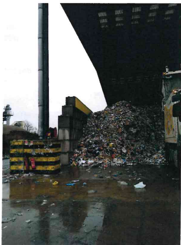
Stockage supérieur au repère de 3,5m
