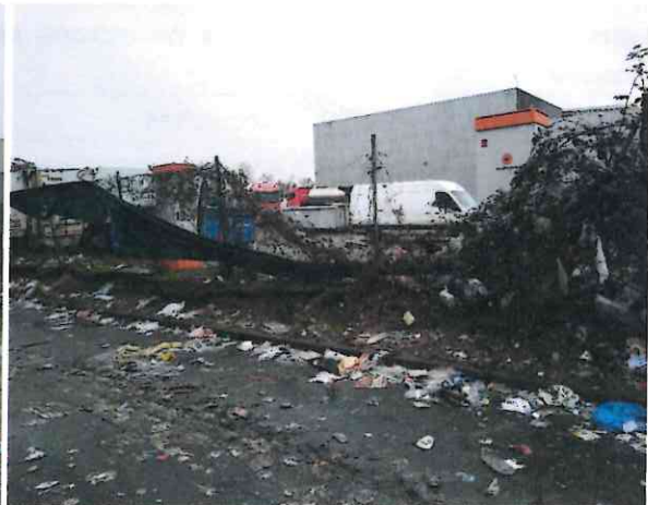
Filets et clôture dégradés et déchets sur les abords végétalisés
