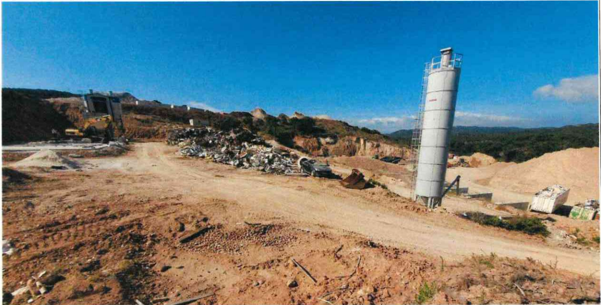
Photo prise sur site le 4 juillet 2023 : centrale à béton
