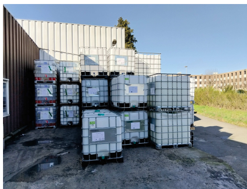
Absence de rétention pour les stockages extérieur
