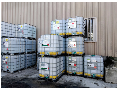
Absence de rétention pour les stockages extérieur
