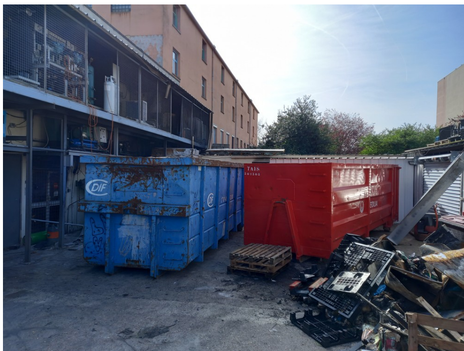
Bennes à déchets présentes dans la cour du site
