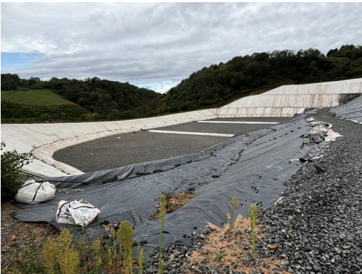
Vue d'ensemble du casier B7
