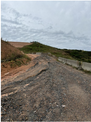
Route d'accès au casier B7
