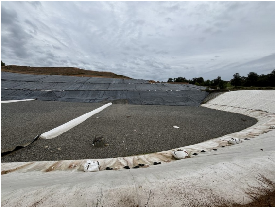
Puit de pompage des lixiviats du casier B7 (point bas)
