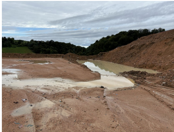
Quai de déchargement et fosse de vidage
