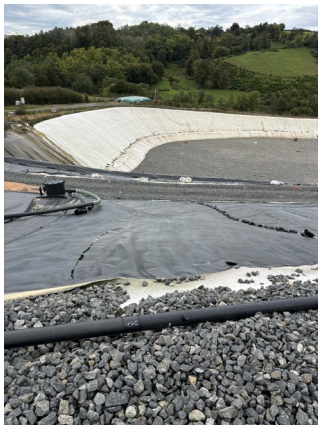
Bande où sera installée la future rampe engin
