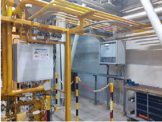
Photo 3 : câblage pour la détection d'H2 (à l'intérieur de l'armoire)
