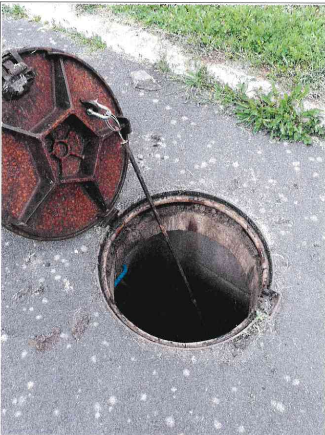
trappe vanne bassin d'orage
