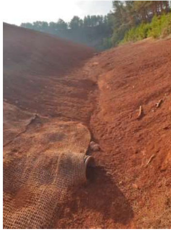
Figure 2: Flanc Ouest des casiers Ouest sur bassin 6
