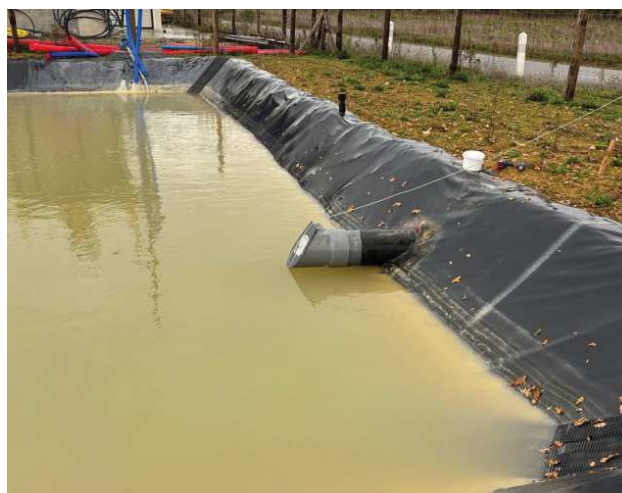
Photographie 1. (12/11/2025 - exploitant) mise en place du dispositif de confinement sur le bassin d'eau pluviale
