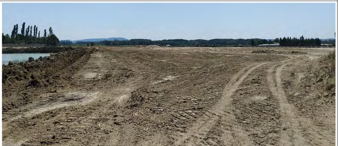
Photo n°2 – zone en cours de décapage au sud du lac n°2
