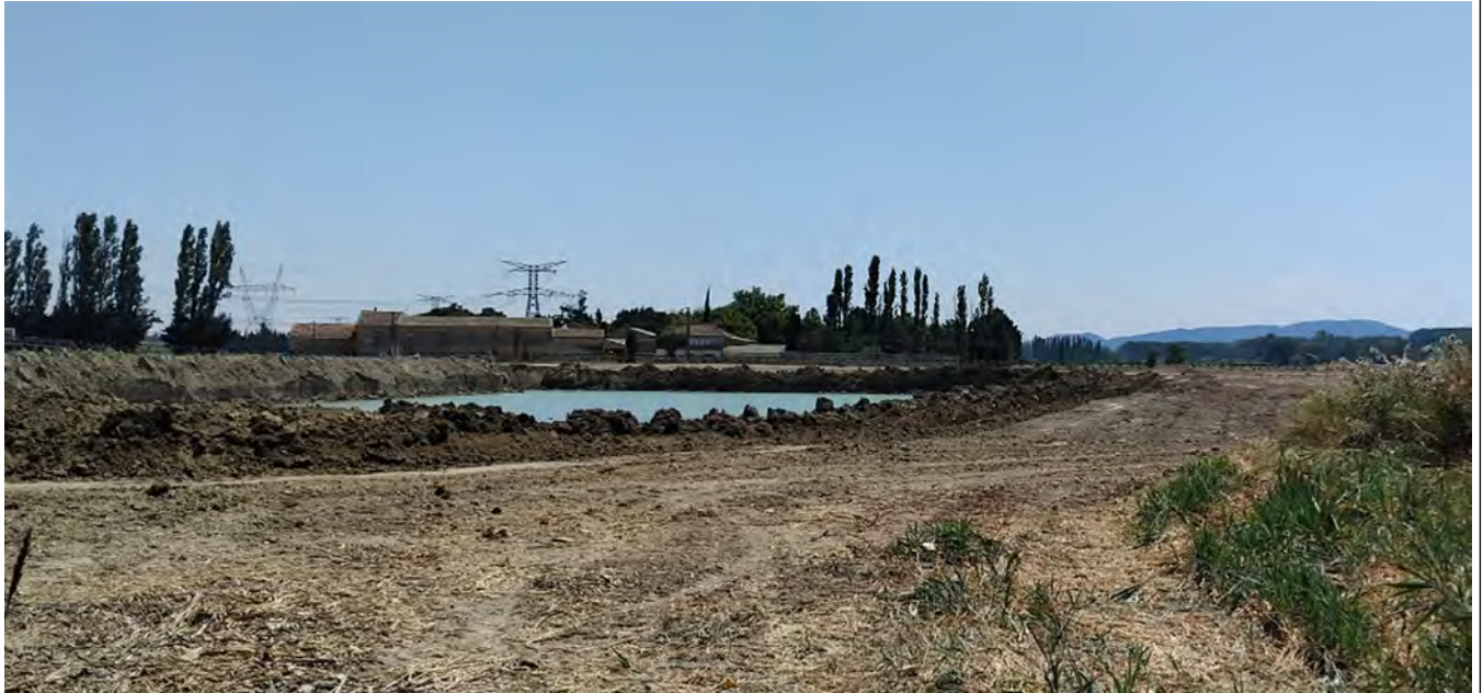
Photo n°1 – zone en cours de décapage au sud du lac n°2
