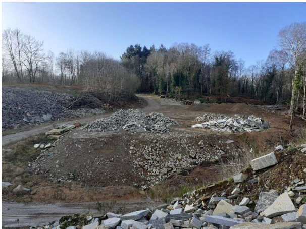
Zone de recyclage des déchets
