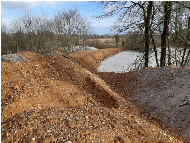
Digue construite pour contenir les boues stockées dans le bassin
