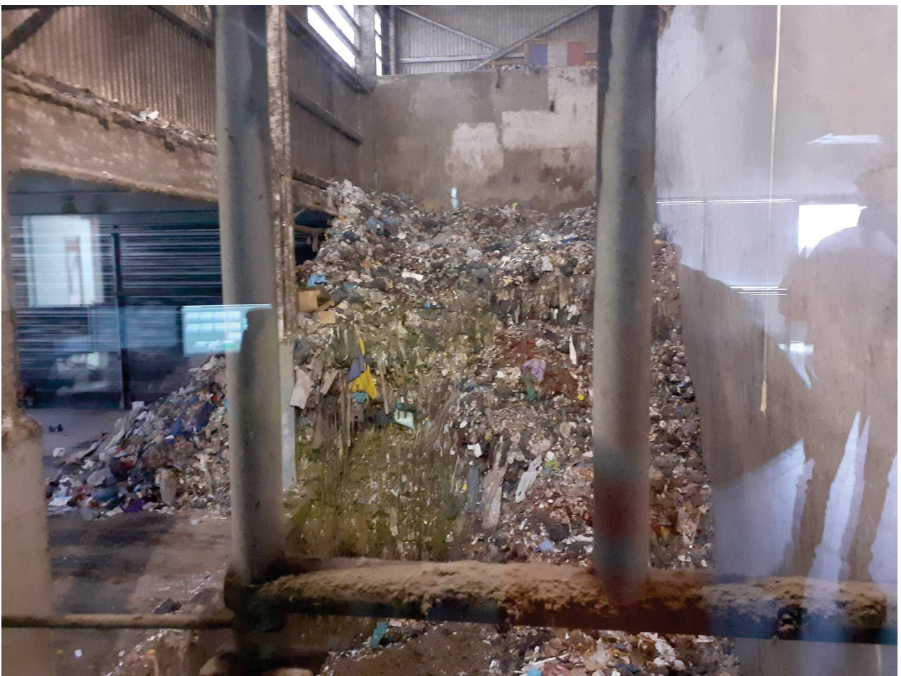
Fosse de réception des déchets
