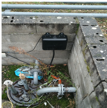
Partie d'équipement de détection de fuite au droit des cuves
