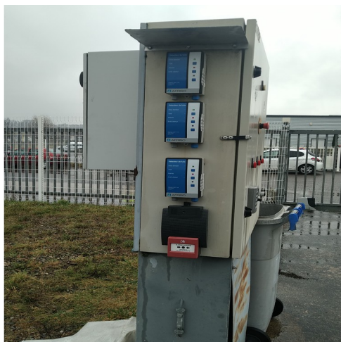
Armoire électrique, support au dispositif de détection de fuite.
