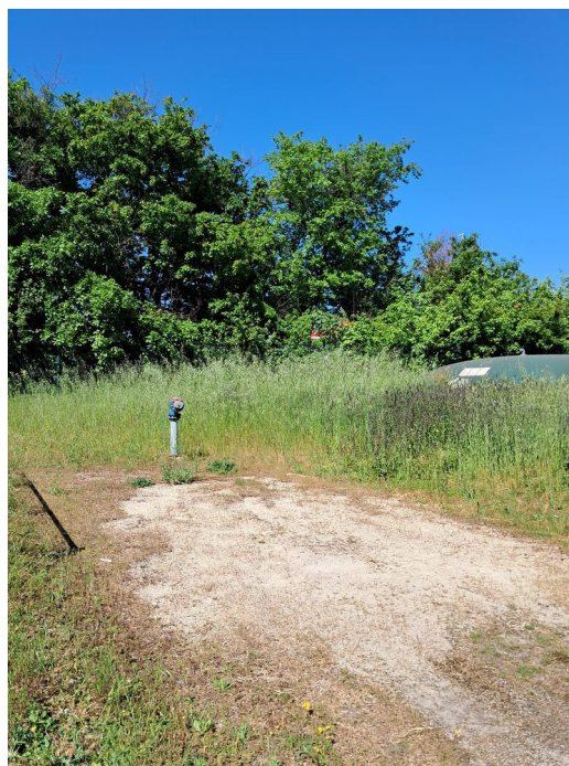
Réserve incendie de 60 m 3
