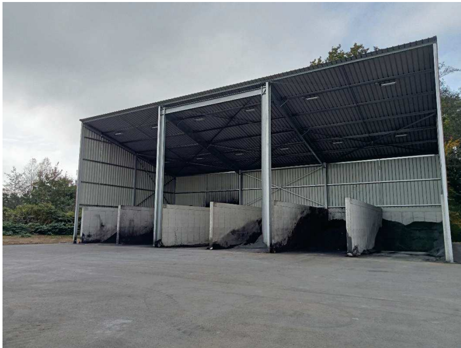
Auvent de stockage et box
