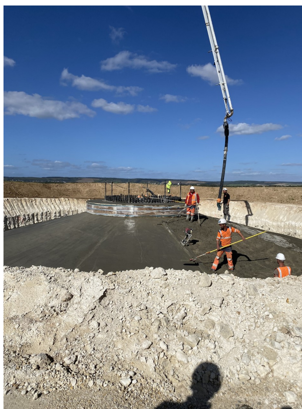
Figure 4 Fondation en construction de l'éolienne E9
