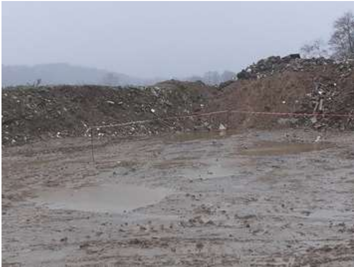
Plateforme de déchargement de déchets inertes matérialisée par des piquets d'ancrage
