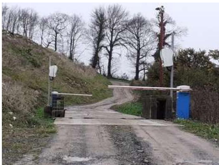
Deuxième barrière entourant le pont bascule
