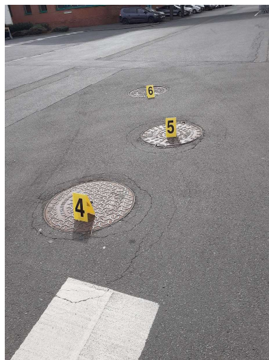
Photo 5 – vanne pour la rétention des eaux d'extinction incendie
