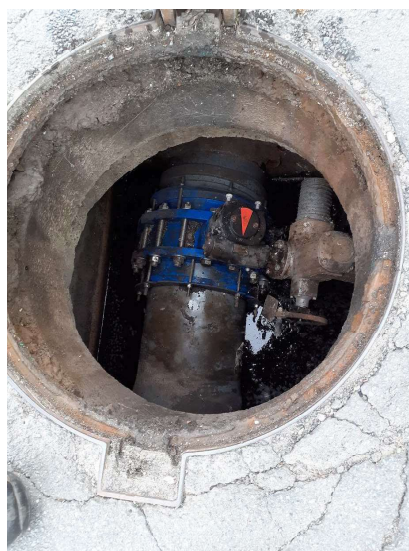
Photo 5 – vanne pour la rétention des eaux d'extinction incendie
