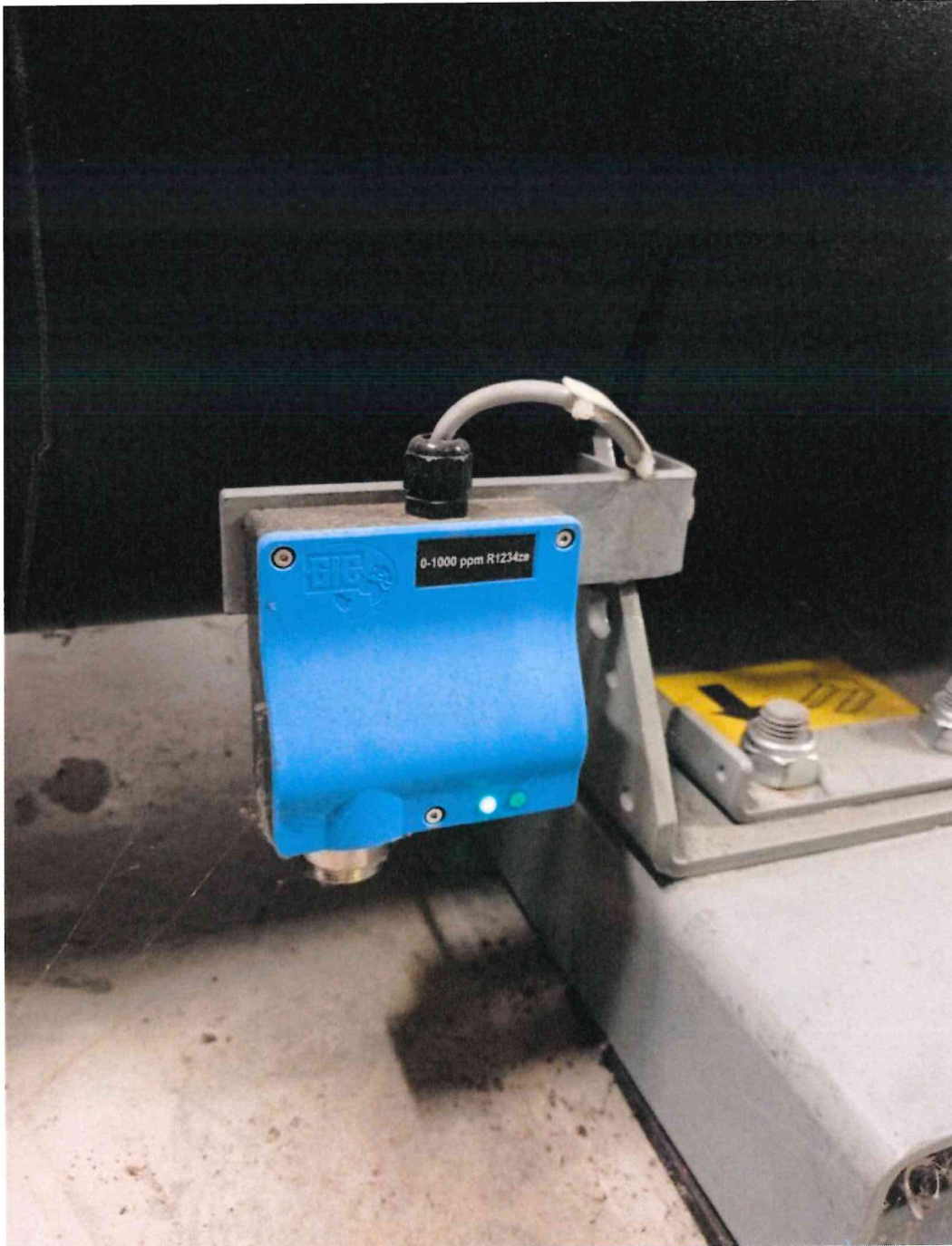
Système_permanent_détection_fuite_HFO
