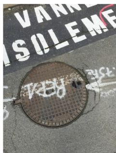
Relevé et repérage en cours avec géomètre (plan de récollement en cours)
