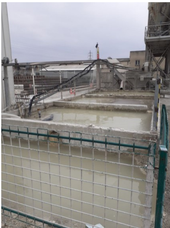
Photo n°1 : bassins de décantation des eaux de process
