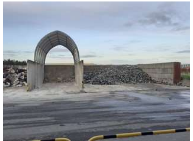
Alvéoles de stockage extérieures de déchets
