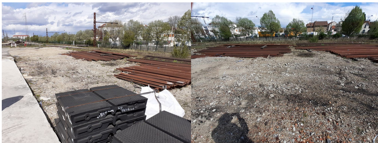
Emplacement du site après le retrait des cuves
