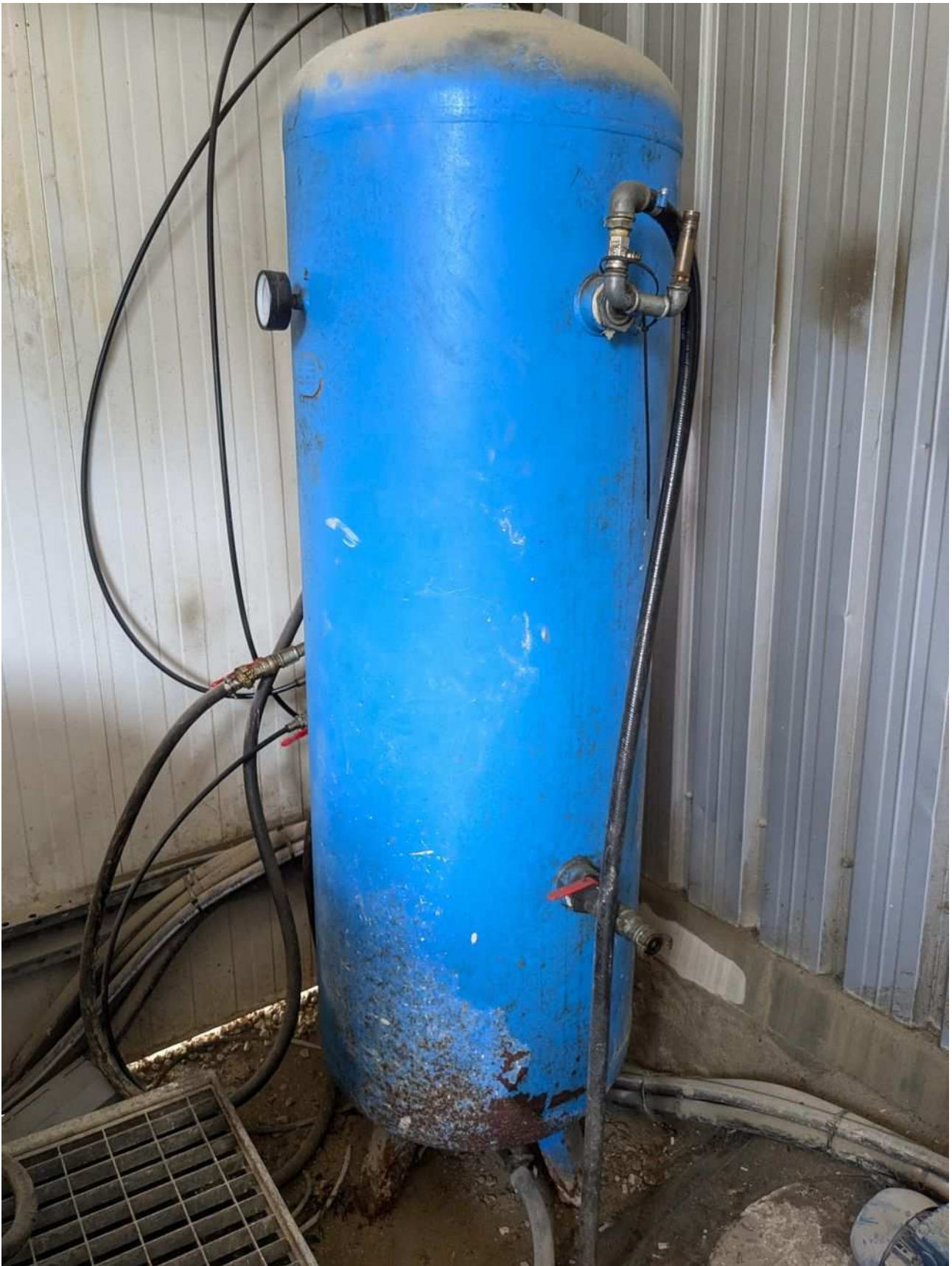
Figure 3: RPS SIAP - vue générale (dégradation fond de cuve et tube en T de support soupape visible)
