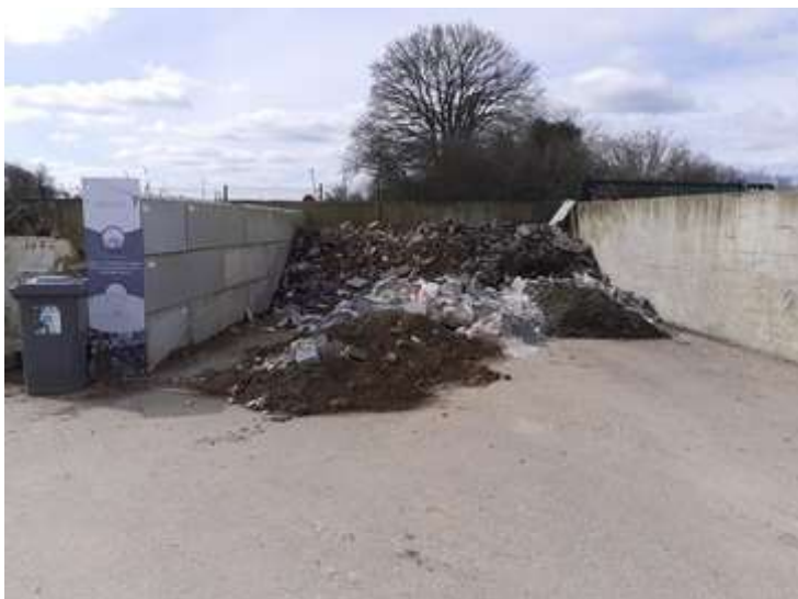
Plateforme de réception et d'entreposage des gravats
