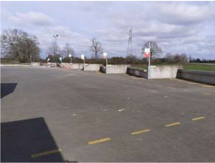
Vue d'ensemble des quais de la déchetterie de Bais
