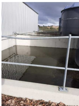
Rétentions autour des cuves (à vider) Zone 2 sur plan ci-dessus
