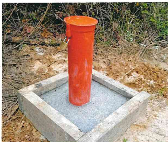
Photographie de l'ouvrage Pz3 :
