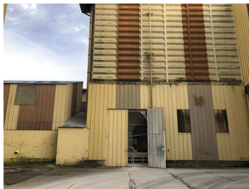
Photographie 2. Porte ouverte (bas de l'installation – partie distribution vrac – pas d'activité de distribution lors de la visite)
