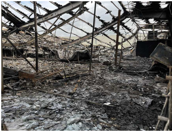
Vue intérieure du bâtiment
