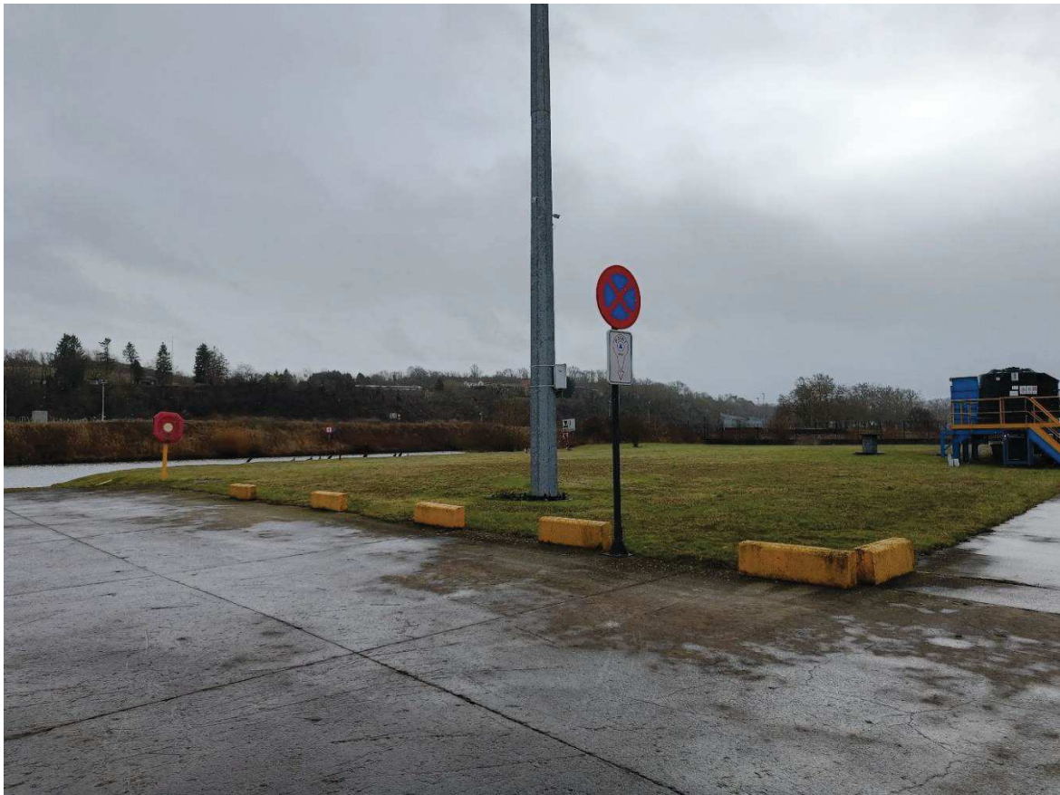
Figure 16 : Affichage de la zone de pompage et de l'interdiction de stationner 2
