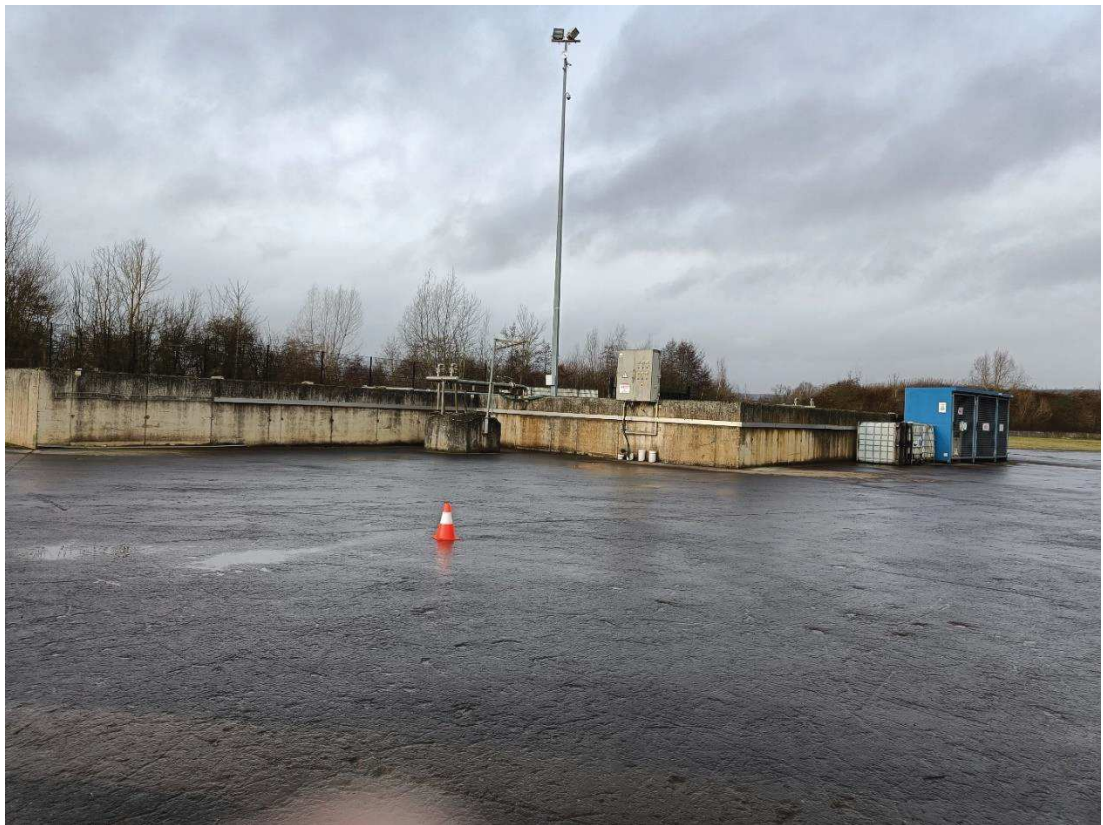
Figure 6 : Station de traitement des eaux pluviales avec séparateur hydrocarbures et rétention incendie
