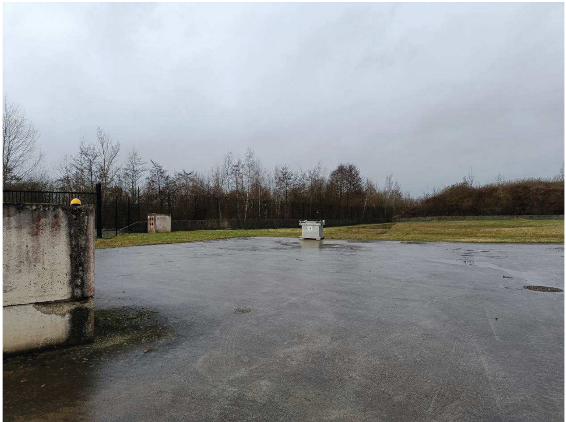
Figure 10 : Container isolé de 1 m 3 de stockage de batteries de lithium
