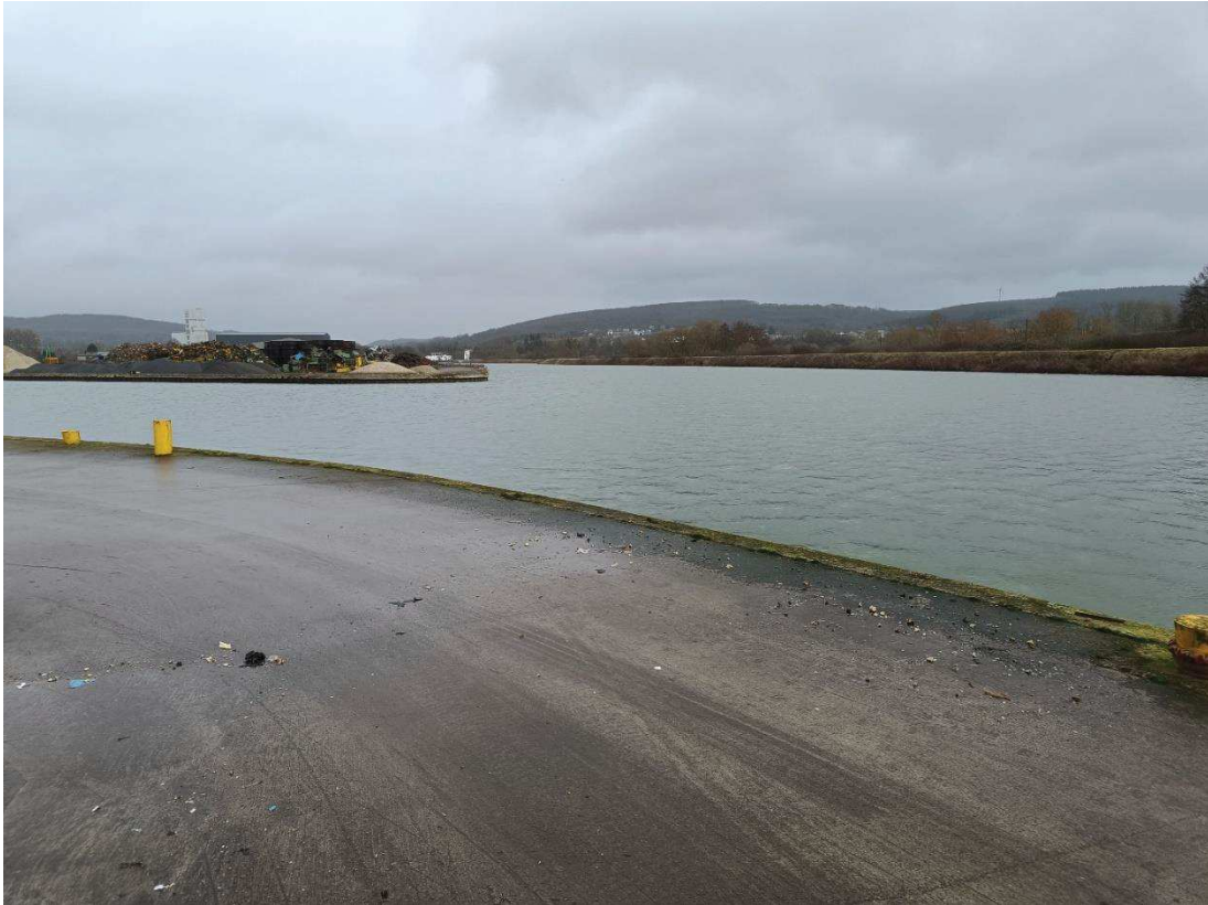
Figure 17 : Zone de pompage pour les pompiers : pas de traçage au sol de l'aire concernée, absence de butées
