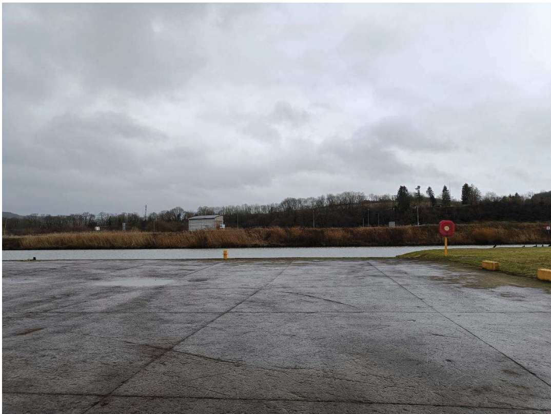
Figure 18 : Zone de pompage pour les pompiers : pas de traçage au sol de l'aire concernée, absence de butées
