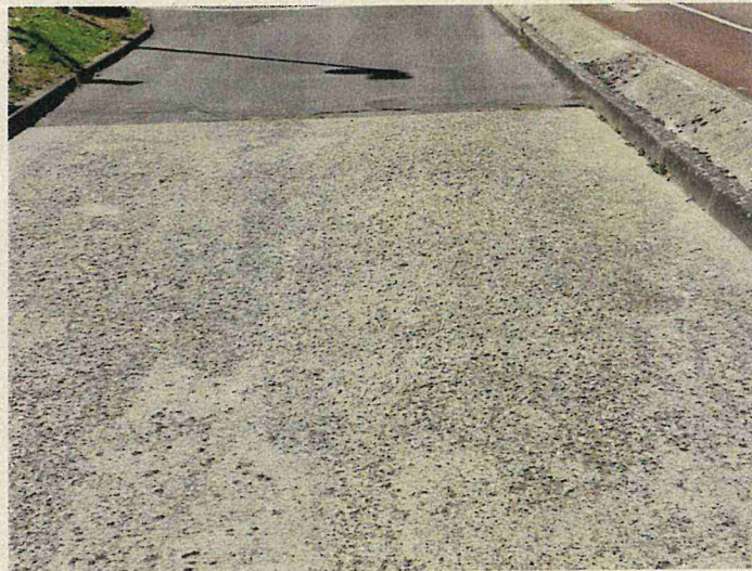
Béton en bon état de la zone de dépotage
