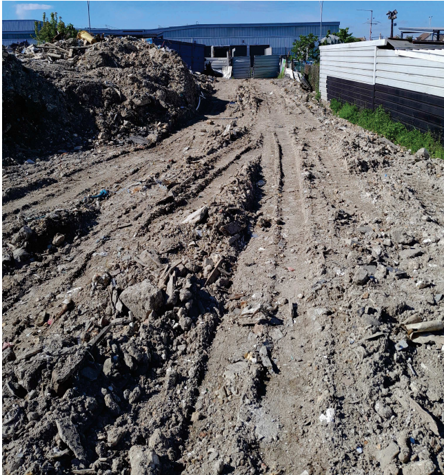
Photo 1 : vue de l'allée principale, 1 er inspection du 07/05/24
